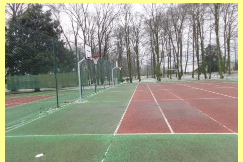
Le site avant les travaux
