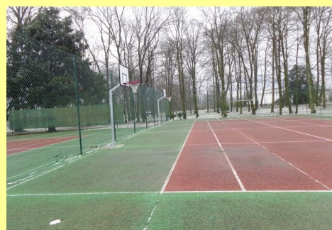
Le site avant les travaux
